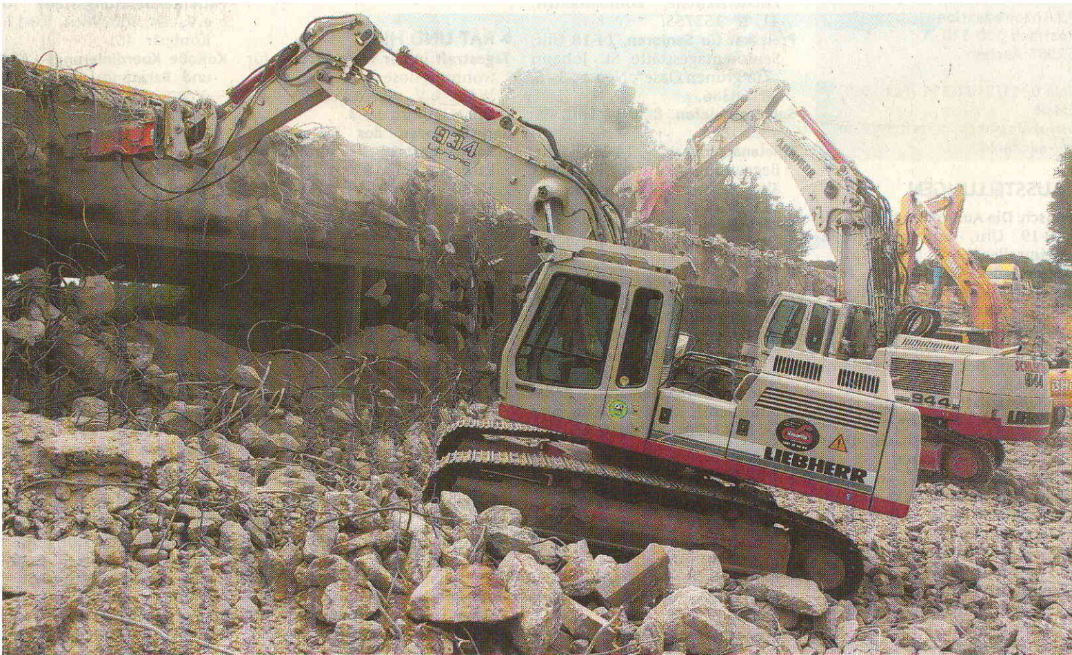
mern, krallen, reißen: Gegen die brachiale Gewalt der bärenstarken Bagger hat die Autobahnbrücke über der Haarener Gracht keine Chance. Das als 50 Jahre alte Bauwerk an der A 544 wird in kleine Bröckchen zerlegt. Fotos: Andreas Steindl (2), Manfred Kistermann
