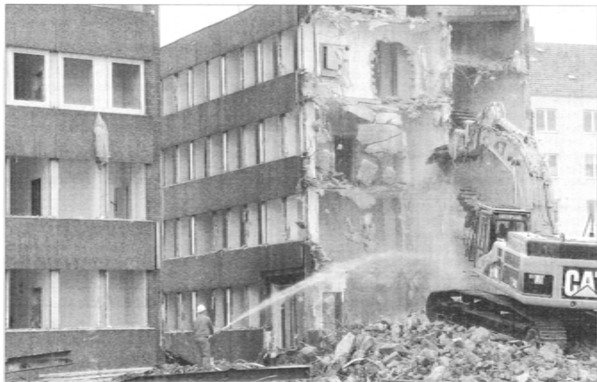
Der Anfang vom Ende: Ein erster Bagger gräbt sich in die Mauern des Landesbehördenhauses an der Franzstraße, das dem Neubau der AachenMünchener weichen wird.
